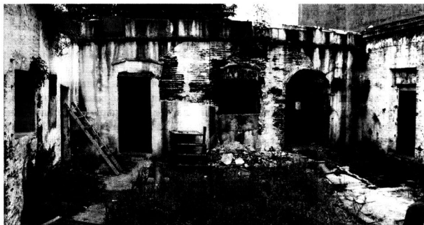
Vista del patio delantero de la casa y sus laterales. Al centro el sector del siglo XVIII. El retiro de los revoques modernos fue parte de la investigación
